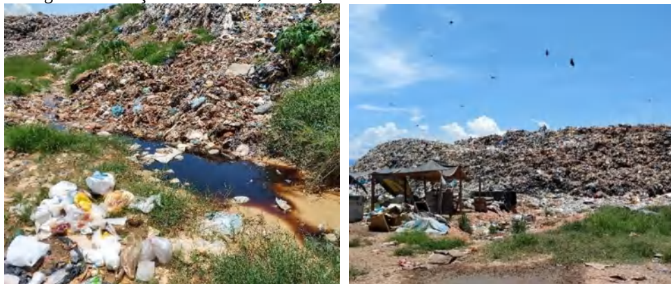
Figura 3-14 Poças de Chorume, Presença de Aves e Falta de Recobrimento
