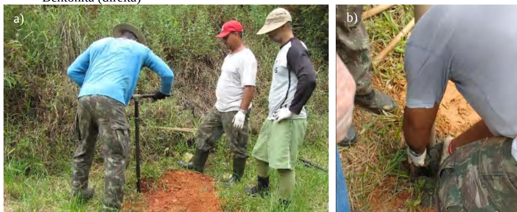
Figura 4-2 (a) Perfuração do Poço 2 com Trado Concha, (b) Preenchimento do Topo com Bentonita (direita)
